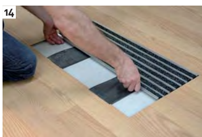
9 Coloque o primeiro perfil de Basmat .
