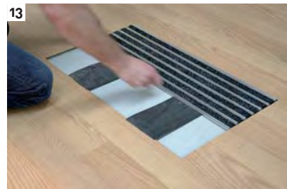
8 Coloque as tiras de espuma pretas auto-adesivas paralelamente umas às outras a uma distância de 30 cm com o lado adesivo virado para cima. Descole a película protectora alguns centímetros.
