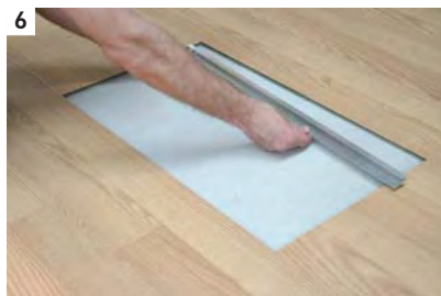
6 Coloque o primeiro perfil de remate.
