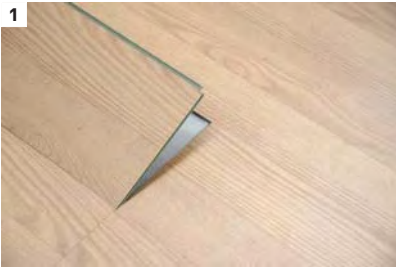
1 Remova as tábuas do local seleccionado, de preferência a partir de um canto do local e corte as irregularidades dos bordos.
