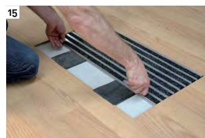
10 Continue a colocar os perfis Basmat encaixados em "clíc" uns nos outros e colados à espuma preta. Continue a retirar a película protectora conforme vai adicionando mais perfis.
