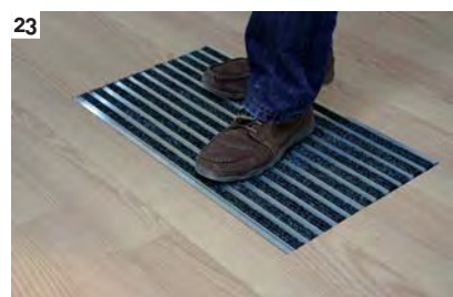
23 A instalação está completa.
