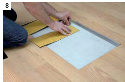
8 Coloque as tiras de espuma pretas auto-adesivas paralelamente umas às outras a uma distância de 30 cm com o lado adesivo virado para cima. Descole a película protectora alguns centímetros.
