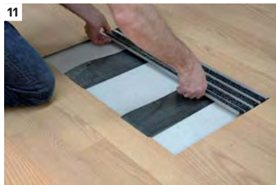
6 Coloque o primeiro perfil de remate.
