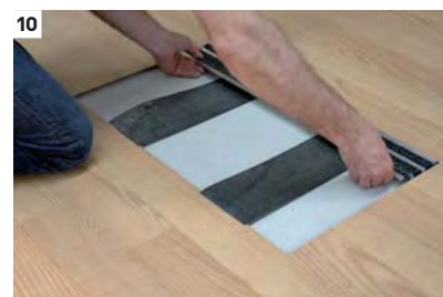
10 Continue a colocar os perfis Basmat encaixados em "clíc" uns nos outros e colados à espuma preta. Continue a retirar a película protectora conforme vai adicionando mais perfis.
