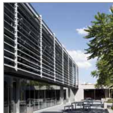
ICARUS 360, Telindus, Haastrote (BE), Arq.: Crepain - Arquitectos Binst, foto: Toon Grobhet
