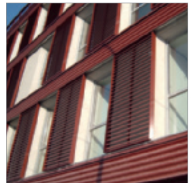
LOGGIA® • Sogima-Salengro • Marseille (FR) Arch.: Dusanpin-Leclercq + Navélet-Zakarian
