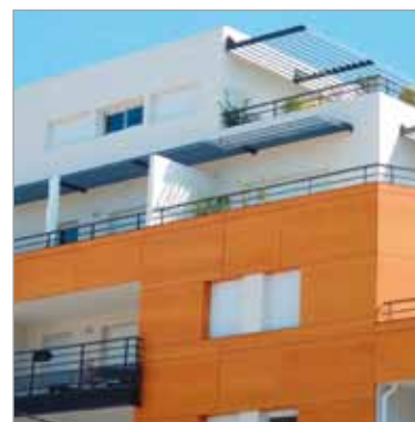
Icarus® Aero 200 sur consoles • Domaine des pins à Montpellier (FR) • Arch: Garcia Diaz à Montpellier
